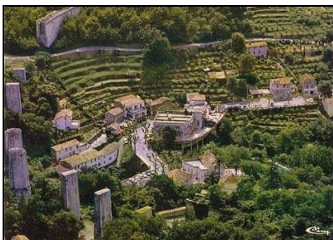
En 1951, par sécurité, il fallut détruire les arches restantes qui menaçaient de s'écrouler Si bien que ne restent que les culées de l'ouvrage et des moignons de piles
