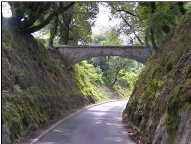
Pont de Ouahigouya
