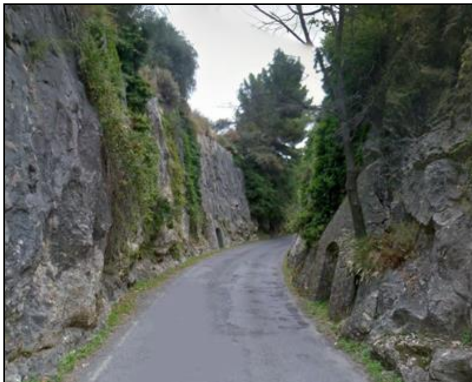
Une profonde tranchée après le viaduc de Cassan Noter les niches abris comme dans les tunnels
