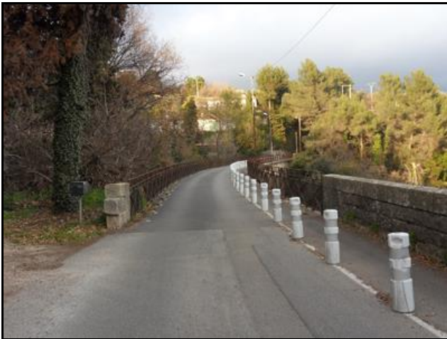
Sur le viaduc
