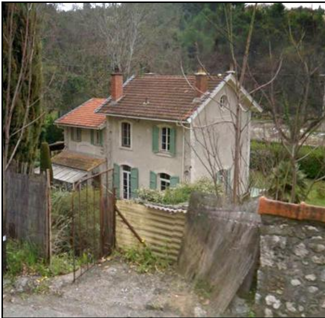
Ci-contre, la gare de Saint Jeannet à la sortie de laquelle se trouvait le tunnel de la Billoire, 860 m de long, lui aussi privatisé, mais laissé dans un état d'abandon qui le rend difficilement accessible
