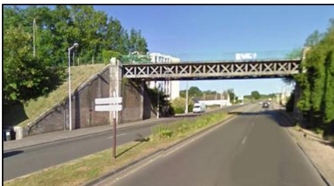
Presque aussitôt suivi du pont à tablier métallique ajouré en treillis au-dessus de la RN 1013
