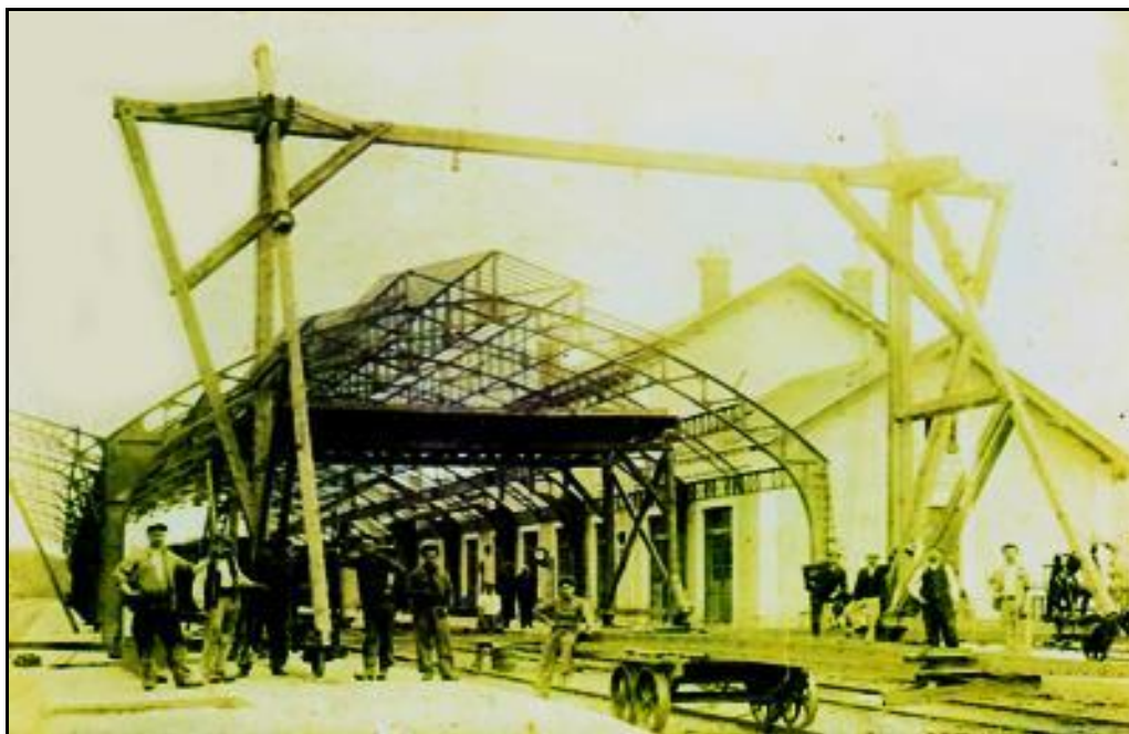
Puis la construction de celle-ci
