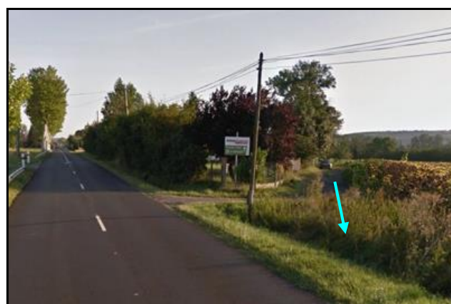
Vue à contresens, la fin de la déviation
