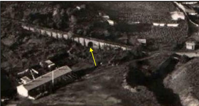
② Un long remblai maçonné avec contreforts et percé d'un second pont (flèche jaune) franchissait une dépression de terrain. Cet ensemble est toujours existant et situé aujourd'hui à côté d'un lotissement. Mais totalement enseveli sous la végétation, son accès est presque impossible et il ne peut être que partiellement perçu depuis les propriétés voisines comme en témoignent les photos ci-après.
