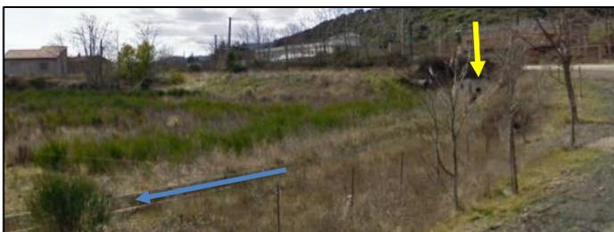
Condamnée et remblayée par du sable pour éviter son effondrement car elle passe sous des zones habitées, cette galerie (flèche jaune) a été équipée d'un drain d'écoulement qui sert d'exhaure avec un canal de fuite en béton (flèche bleue). Ce dispositif évite que toutes les anciennes galeries du Mont Sénégra se remplissent d'eau avec des conséquences qui pourraient être désastreuses.
