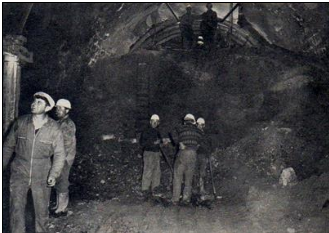
Intrusions dans le tunnel par le nord Les cintres métalliques sont clairement visibles
