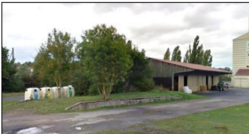
La plateforme de la gare de Nomeny est en partie reprise par une coopérative agricole mais la halle à marchandises est toujours bien visible
