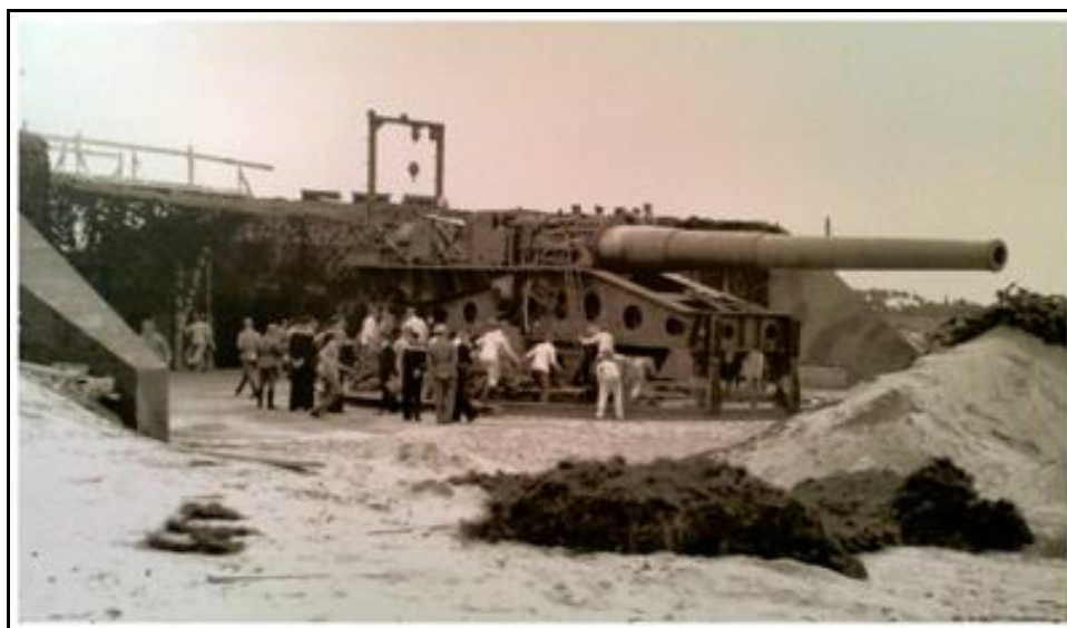
L'un des canons en cours d'installation au Bégo
