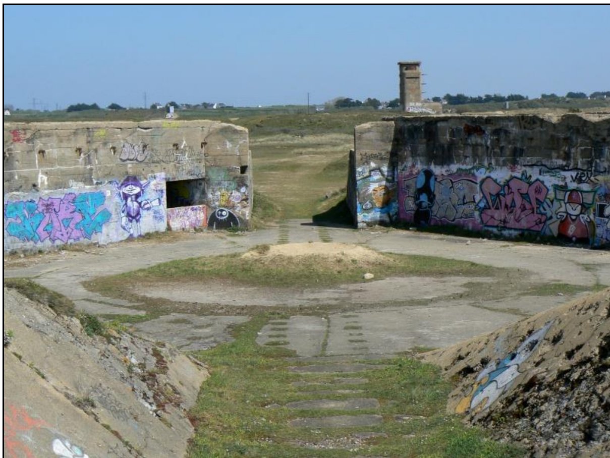
Un résumé complet avec le poste de conduite de tir, la cuve de tir, le bunker à munitions à gauche, et le garage pour le canon au premier plan
