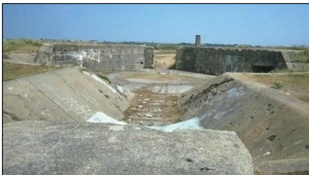
Ci-dessus et ci-après, gros plans sur une position de tir Notez, sur ces deux photos, la tour du poste de conduite de tir à l'arrière plan Et sur la photo ci-dessus, au premier plan, le garage de camouflage du canon
