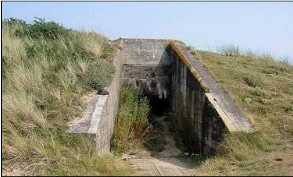
Soute à munitions souterraine Notez les rails destinés à des wagnnets pour faciliter les manutentions
