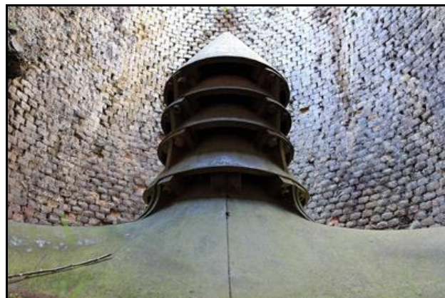
A gauche, le gueulard de remplissage du four à griller des Ménerots et à droite, la cheminée par laquelle sortaient les gaz chauds sous le minerai, au fond du four
