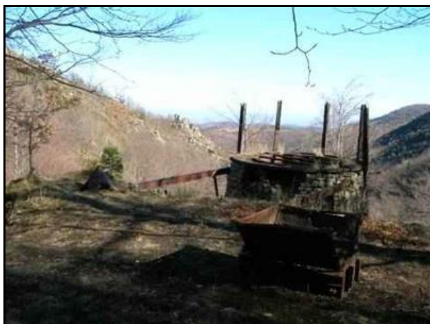
A gauche, le gueulard de remplissage du four à griller des Ménerots et à droite, la cheminée par laquelle sortaient les gaz chauds sous le minerai, au fond du four
