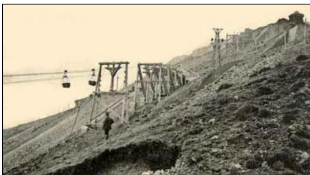
Le transbordeur aérien des mines voisines de Batère, qui était très ressemblant à celui de Formentère On aperçoit à droite le sommet de la tour du four à calciner le minerai de fer
