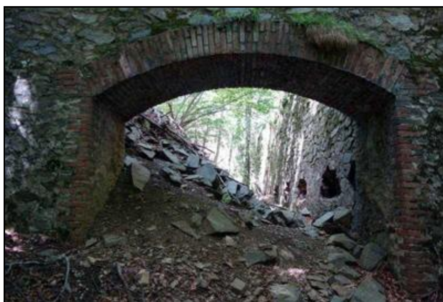
Derrière le portail par où passait le petit train minier, le mur de soutien des trémies de stockage et les trous des trappes de chargement des wagonnets
