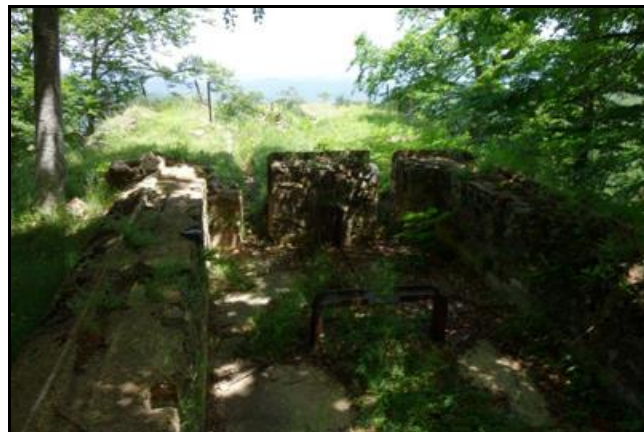
Au-dessus du pont, les maçonneries qui soutenaient la station supérieure avec le support métallique de sa poulie de renvoi toujours visible
