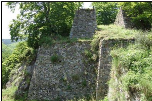
Au-dessus du pont, les maçonneries qui soutenaient la station supérieure avec le support métallique de sa poulie de renvoi toujours visible
