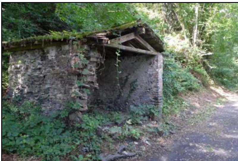
Puis, à mi-chemin entre le tunnel de Cambon et celui de la Mascatié, ce petit abri d'usage exact inconnu qui se meurt doucement
