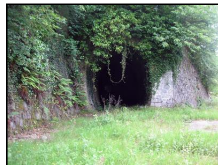
La petite galerie du raccordement triangulaire, 33 m de long, côté Brassac et côté Lacaune Elle est pratiquement perpendiculaire à l'axe du viaduc Murée en son milieu, elle sert de débarras agricole
