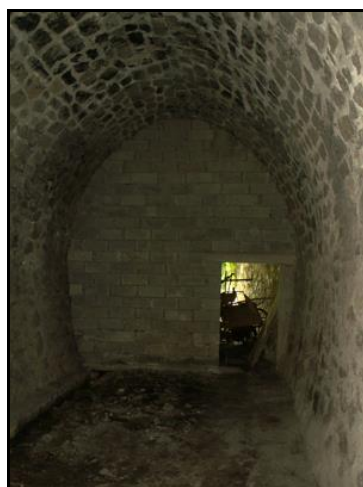
La petite galerie du raccordement triangulaire, 33 m de long, côté Brassac et côté Lacaune Elle est pratiquement perpendiculaire à l'axe du viaduc Murée en son milieu, elle sert de débarras agricole
