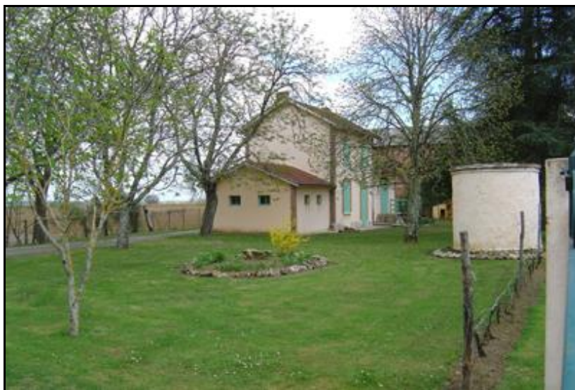
Autre vue de la gare de Bourg avec l'embase en maçonnerie de son château d'eau, toujours présente
