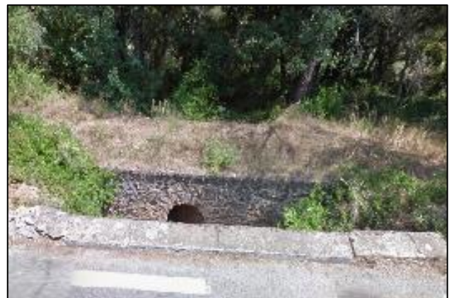
Ponceau intact du ruisseau du Révau
