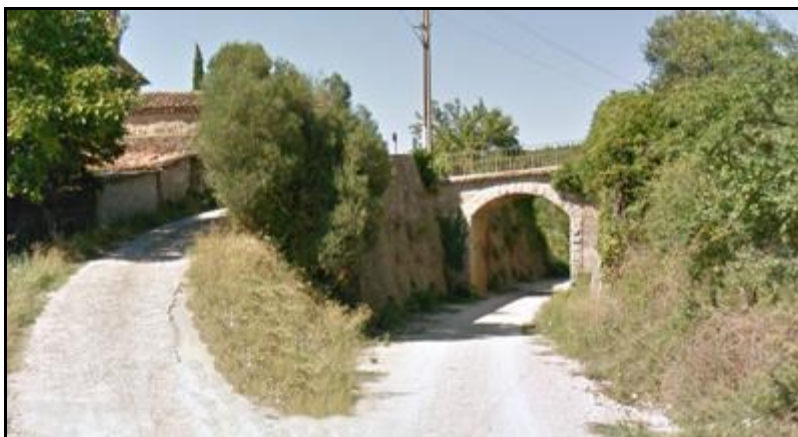
Vu à contresens, le pont de Sauve Clare Il annonce une série de trois tunnels successifs
