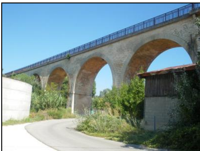
Le viaduc de la Riaille 180 m de long, 20 m de haut et 15 arches plein cintre en maçonnerie
