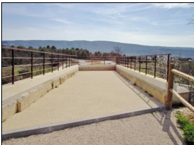
Le dessus de la culée aménagé en point de vue
