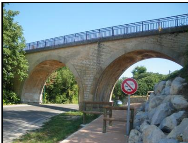
Le viaduc de la Riaille 180 m de long, 20 m de haut et 15 arches plein cintre en maçonnerie
