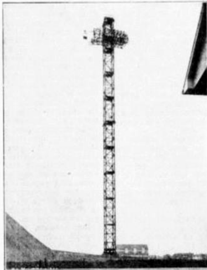
FIG. 10. — PYLÔNE TERMINANT UN TÉLÉPHÉRIQUE « MONZIÈS » POUR LA MISE EN « TERRIL », C'EST-À-DIRE POUR LE STOCKAGE EN TAS DE DÉCHETS D'INDUSTRIES
