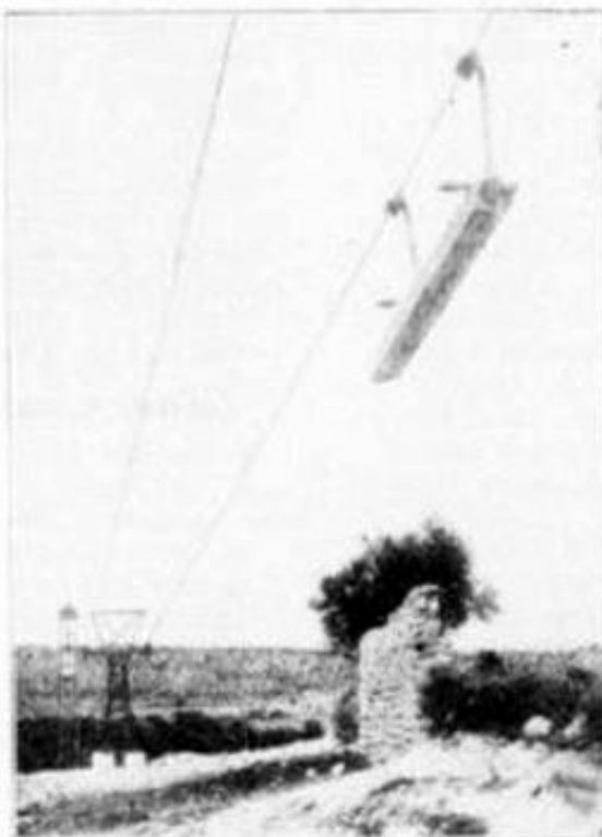
FIG. 9. — TÉLÉPHÉRIQUE « ETCHEVERRY » POUR LE TRANSPORT DE FLANCHES
