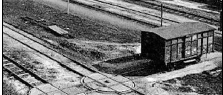
Et wagon stationné sur une voie de manoeuvre
