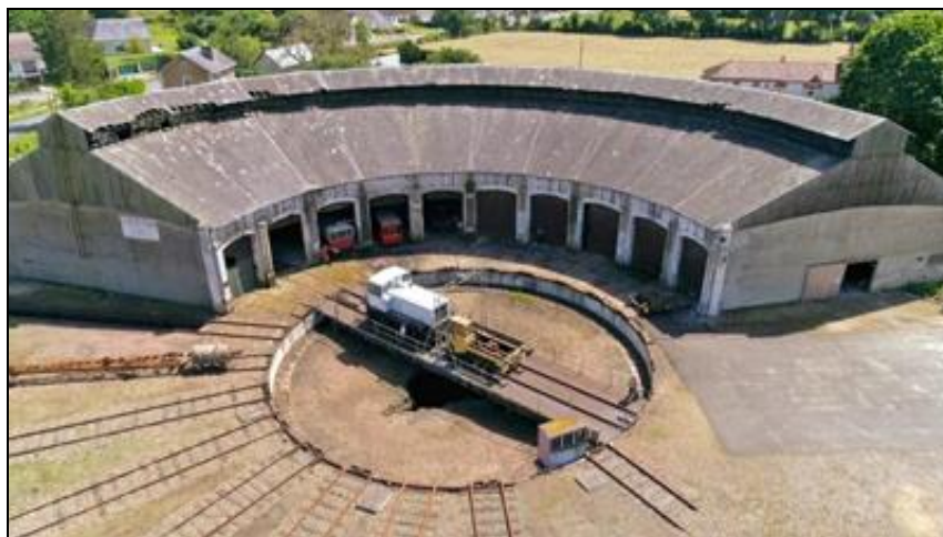
Photo montrant un dépôt en demi-rotonde avec partie en remise de plein air
