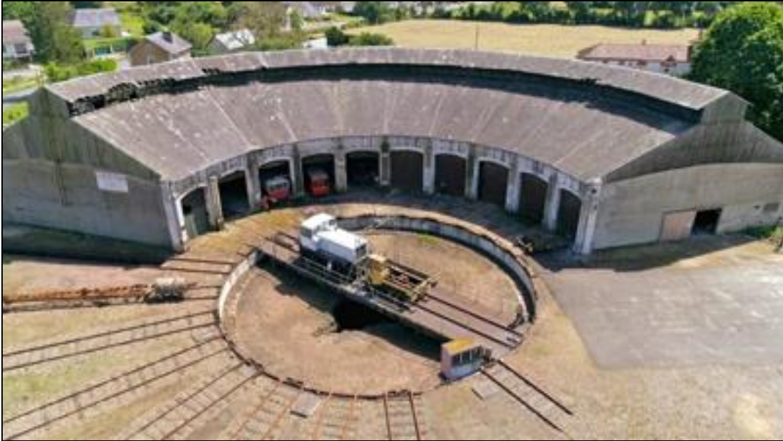
Photo montrant un dépôt en demi-rotonde avec une partie en étoile de plein air
