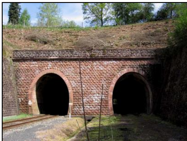
L'entrée du tunnel est ici à gauche
